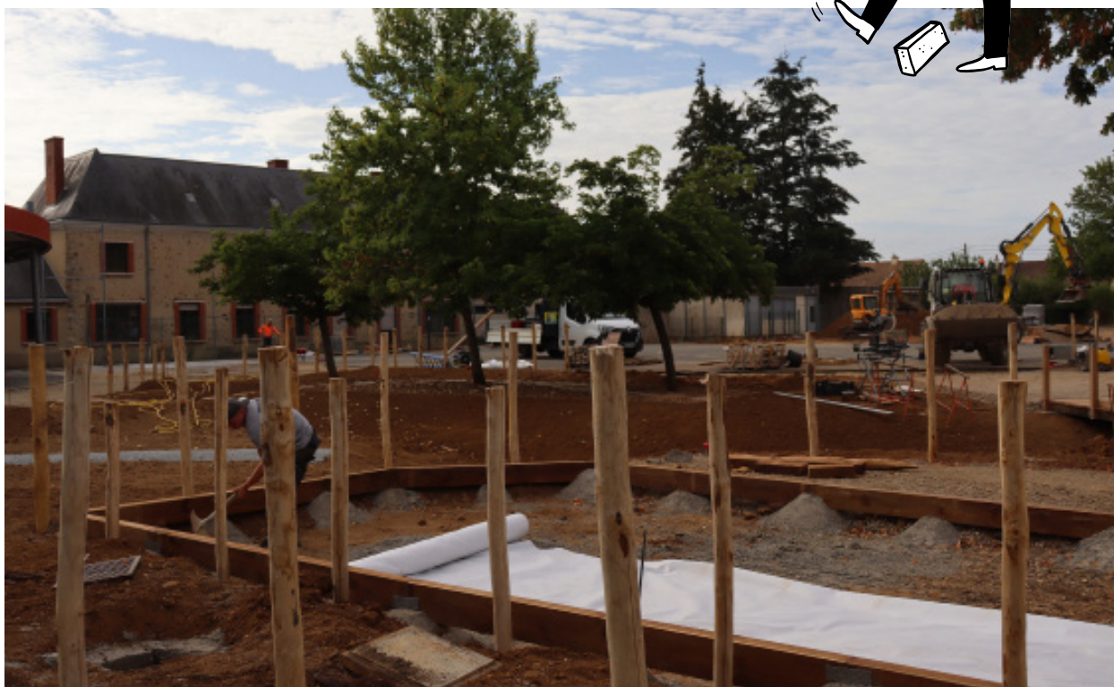
État d'avancement des travaux en août 2026.
